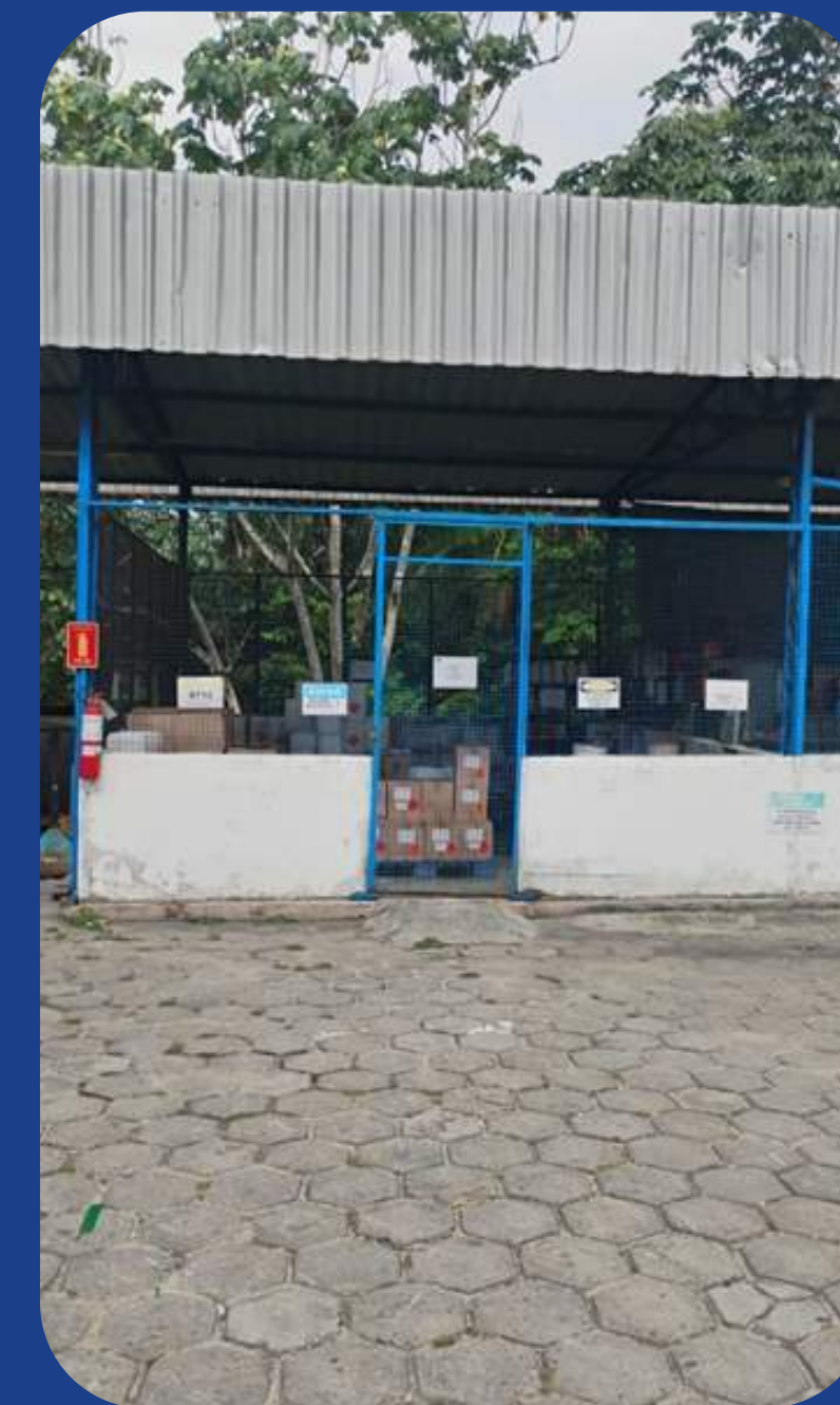
Figura 26– Área para armazenamento e controle.
